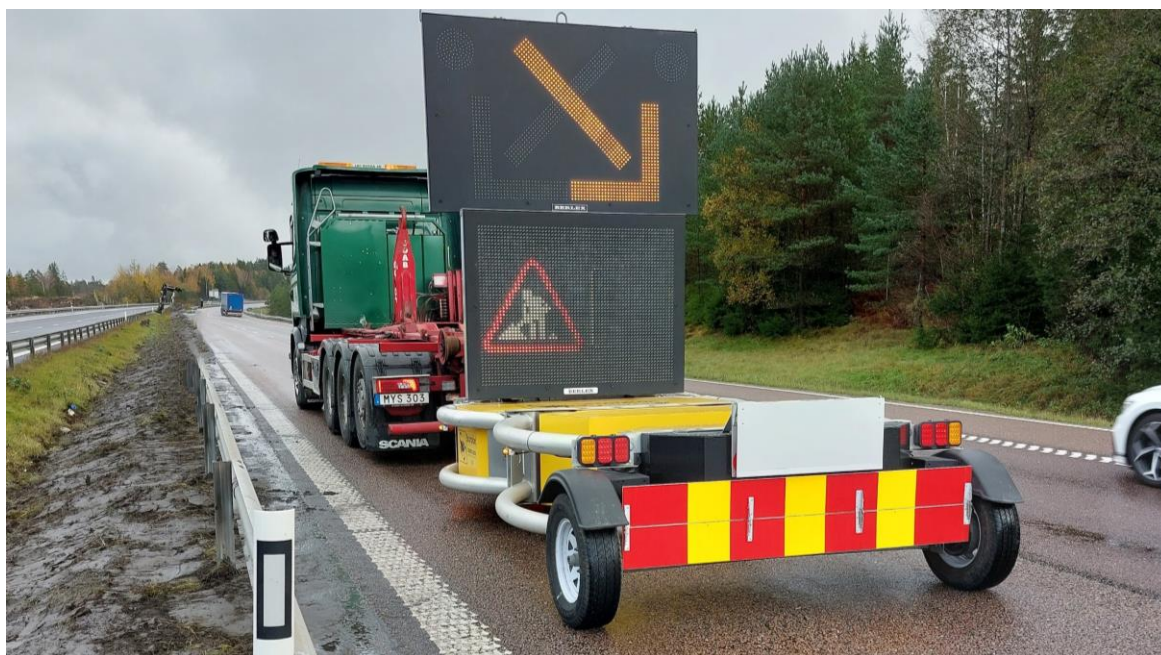
TMA-fordon med TMA-skydd vid kantskärningsarbete på riksväg 40. Foto: Eva Liljegen.
