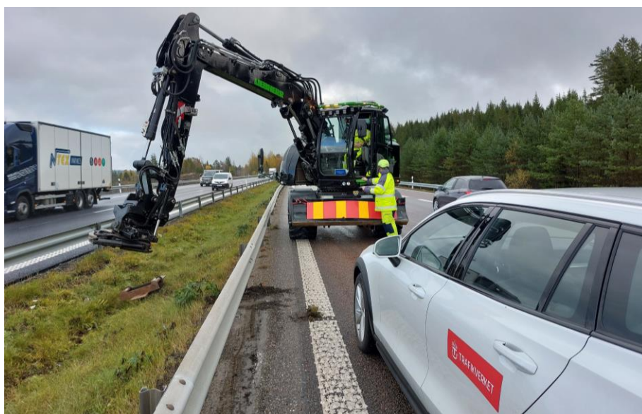
En av Trafikverkets arbetsplatskontrollanter gör en kontroll på ett arbete med kantskärning på riksväg 40. Foto: Eva Liljegren.
