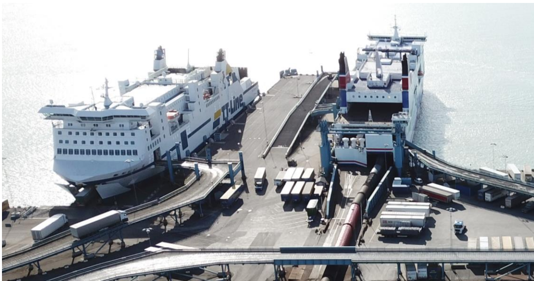
Konventionell RORO-färja till vänster och en tåg färja till höger lastar i Trelleborg. Skillnaderna mellan ett enkelt RORO-färjeläge och ett tåg färjeläge framgår med tydlighet. Foto: Trelleborgs Hamn.
