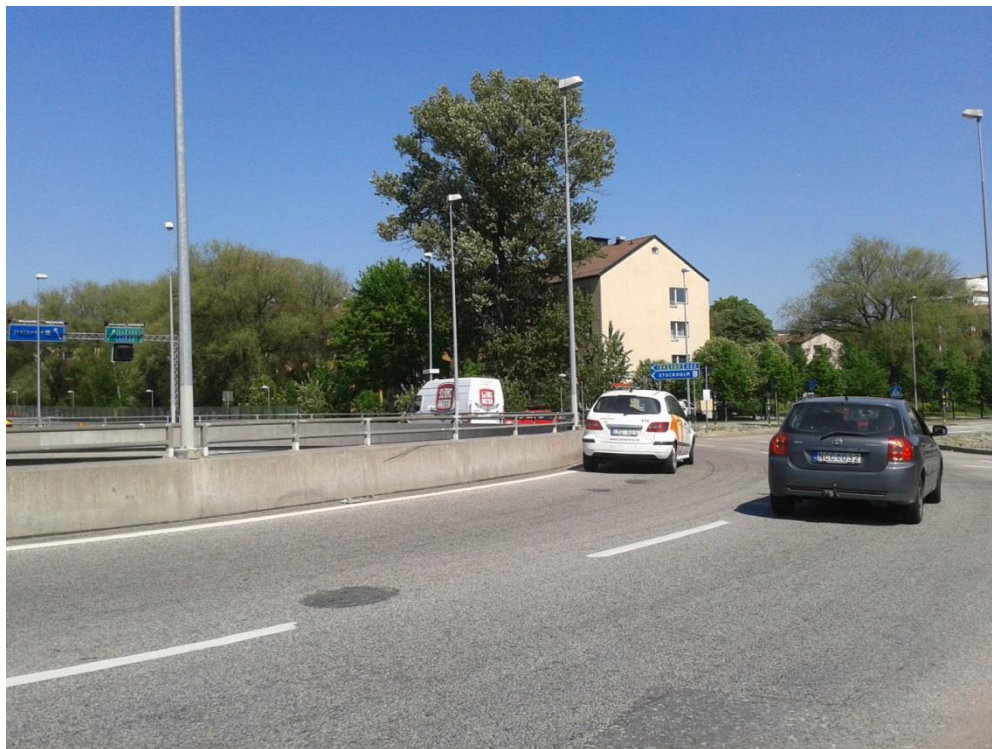
Bild 10 Räcke ovanpå en hög betongkant på brokonstruktionen
