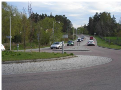
Bild 3 I en vanlig cirkulationsplats är sikten för inkommande fordon betydligt bättre än i en överliggande
