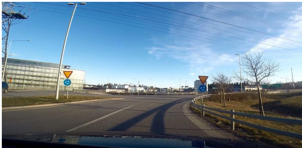
Bild 5 Det enda som upplyser bilföraren om att vägen upphör i ett cirka sex meter djupt hål 30-40 meter längre fram är vägmärken för cirkulationsplats. Räcket är ett vanligt lågt vägräcke.
