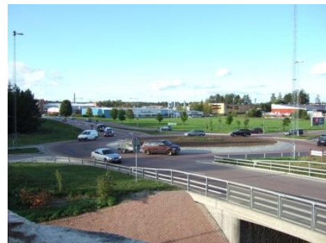
Bild 3 I en vanlig cirkulationsplats är sikten för inkommande fordon betydligt bättre än i en överliggande
