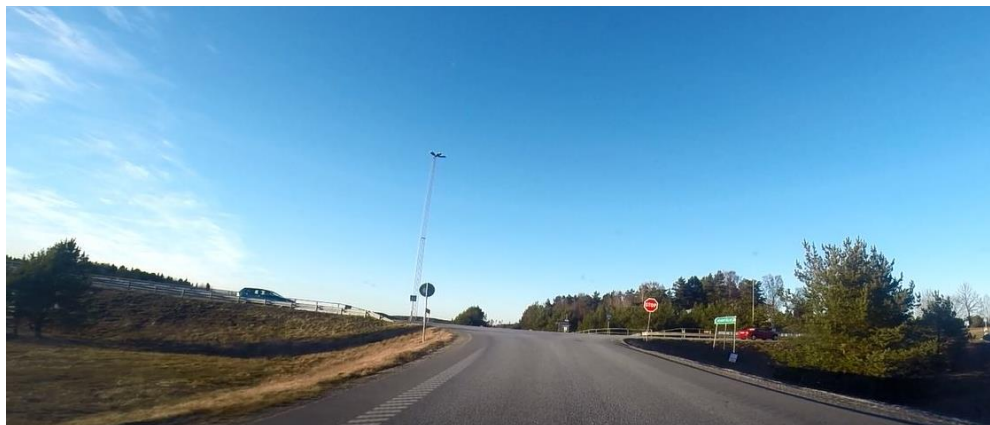
Bild 17 Stopplikt i trafikplats med skymd sikt på grund av räcke och vägprofil
