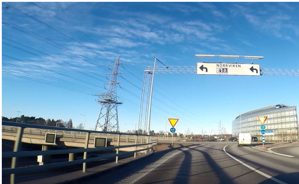
Bild 16 Här är det svårt att se om någon kommer inne i cirkulationen. I praktiken behöver de flesta förare stanna innan de kör in i cirkulationen.
