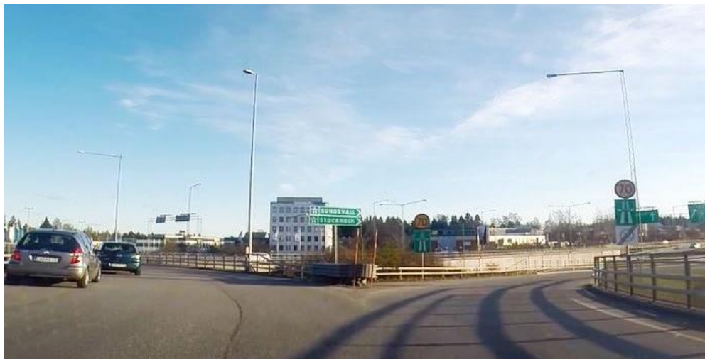
Bild 19 Räckesände inne i cirkulation som är försedd med krockdämpare
