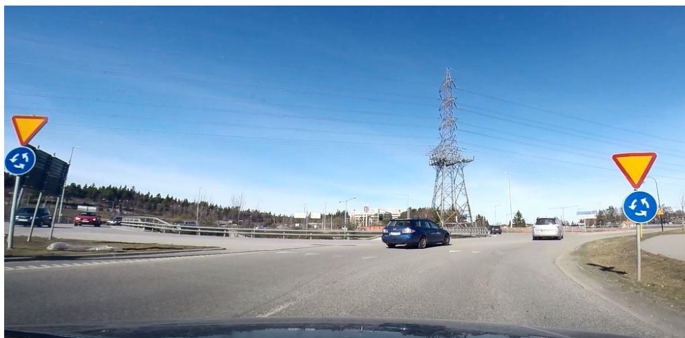
Bild 15 Trots att det på denna plats har skett en genomkörning med allvarliga personskador har inga åtgärder vidtagits för att förhindra att det sker igen
