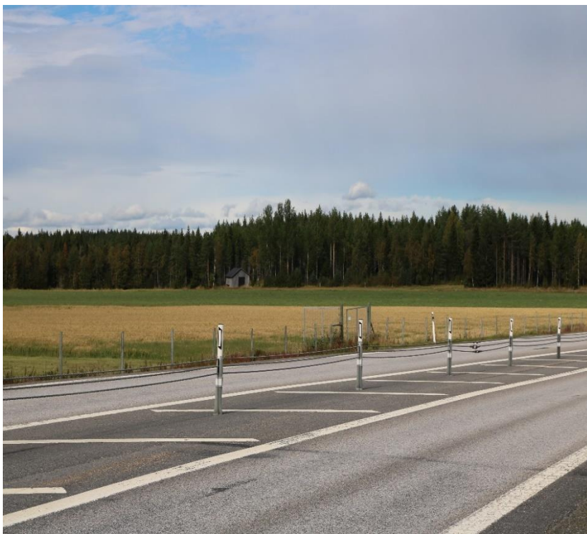
Räcke med hängande linor (för låg linspänning)
