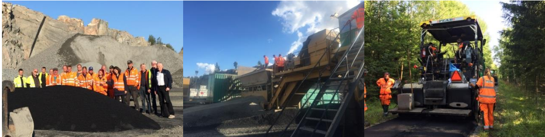
Figur 10. Vänster: del av arbetslaget vid fältförsök i Uppsala. Mitten: ångturboverket, Höger: läggningen.
