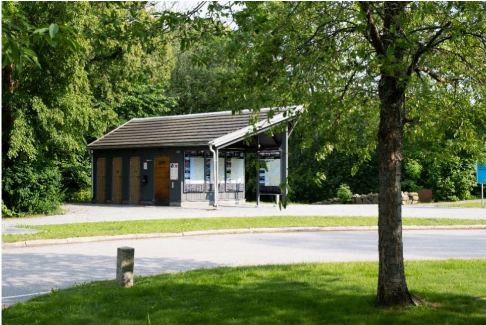
Figur 27: Exempel på rastplats. Foto: Trafikverket
