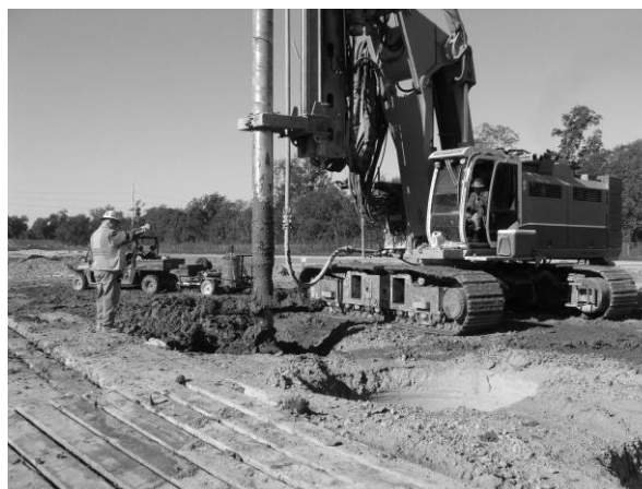
Figur 12. Borrigg våt metod, enkel axel, 1 x \varnothing 2,4 m (T. Forsberg)
