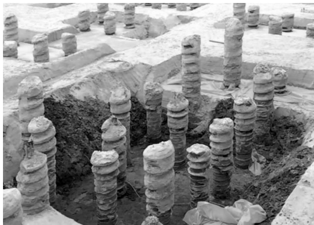
Figur 45. Framschaktade Atlas-pålar (från Franki Grundbau)
