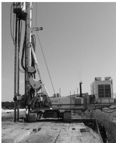
Figur 11. Borrigg våt metod, två borraxlar, 2 x \varnothing 1,6 m (T. Forsberg)
