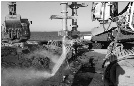
Figur 7. Trevi Turbojet – mekanisk inblandning med högt utmatningstryck (från TREVIICOS, TREVI GROUP)
