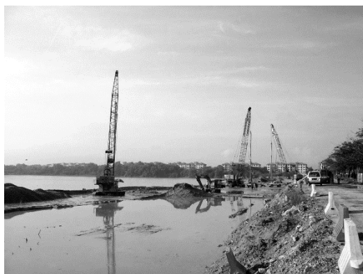
Figur 17. Utförande av våt metod (från Keller PLC)
