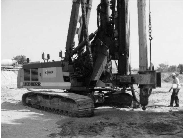
Figur 27. Pelare typ CMC med vibrerande teknik (T. Forsberg)
