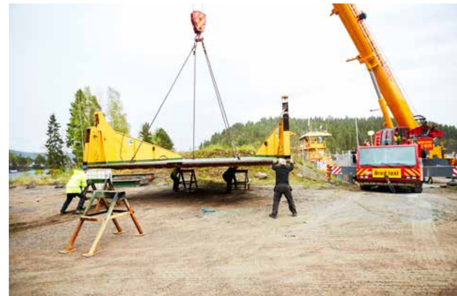
Lee-Floras ramp placeras på bockar inför renoveringen. Rampen som väger 11 ton lyfts på plats av en mobilkran.
