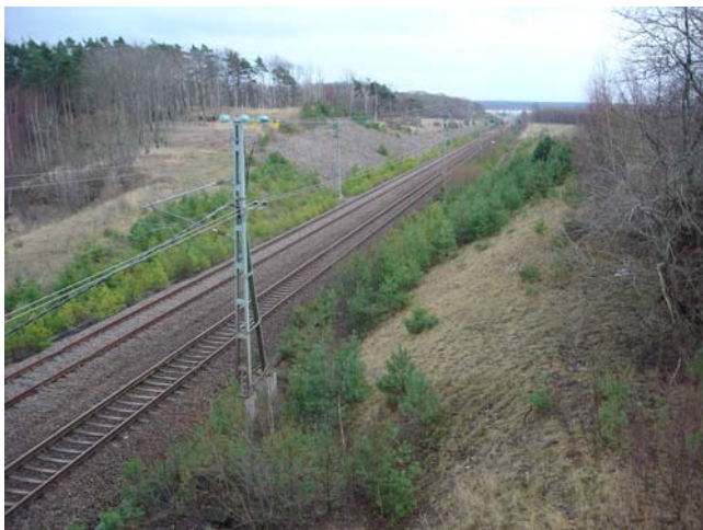
Hållplatsläge Barkåkra. Vy söderut från vägbron (Skepparkroksvägen)
