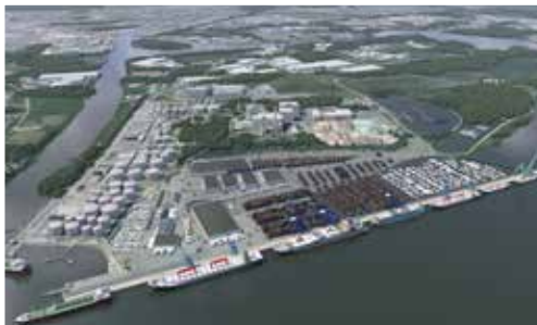
Bilden visar utbyggnaden. Den högra halvan av kajen är den kommande tillbyggnaden med förlängd kaj, utökad hamnbassäng, ny utökad containerplan och en ny tunglyftskran inklusive vägar och spår.
