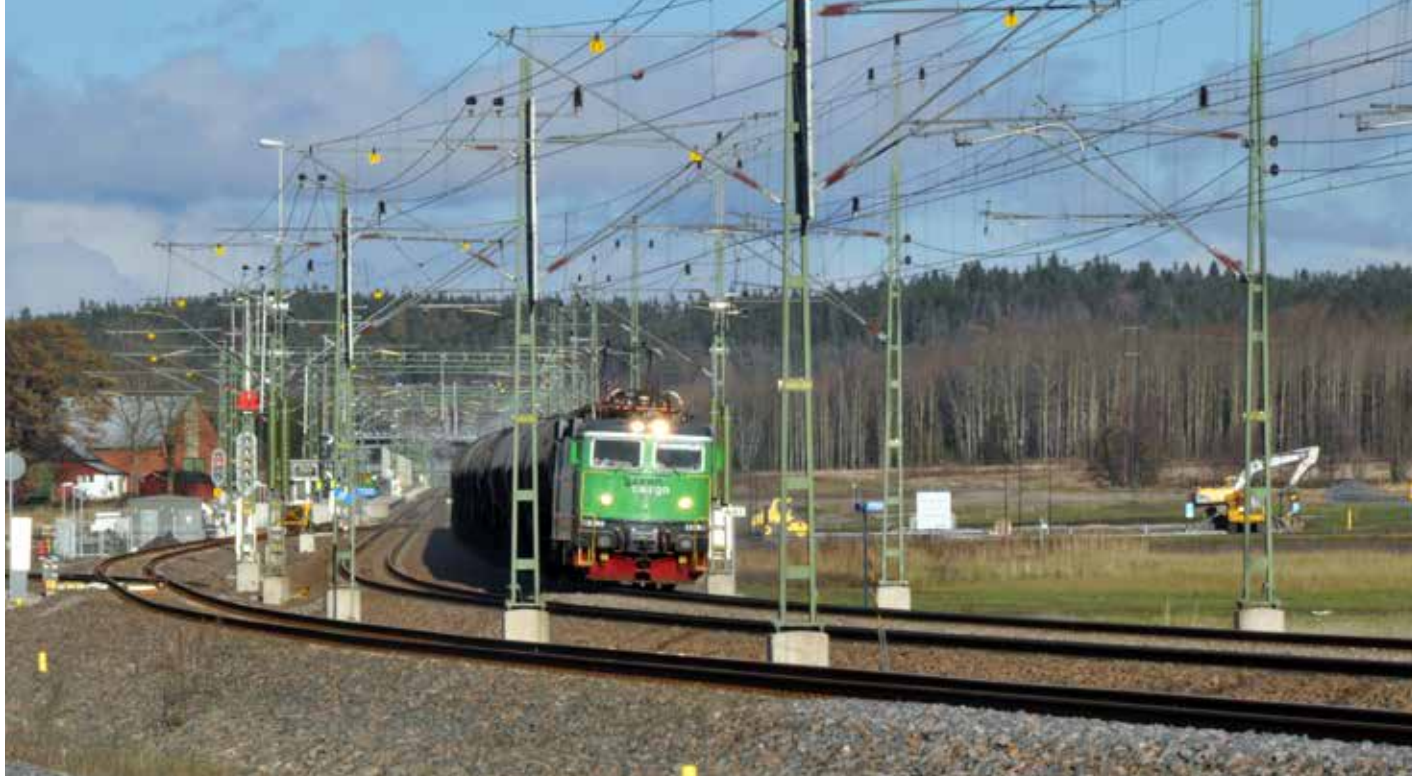
Dubbelspåret mellan Göteborg och Trollhättan har ökat kapaciteten för gods- och persontåg. På lång sikt är målet dubbelspår hela sträckan Göteborg-Oslo. I väntan på det föreslår en norsk-svensk rapport en rad mindre, snabba åtgärder som ska stärka järnvägens konkurrenskraft. FOTO: STEFAN BRATT
