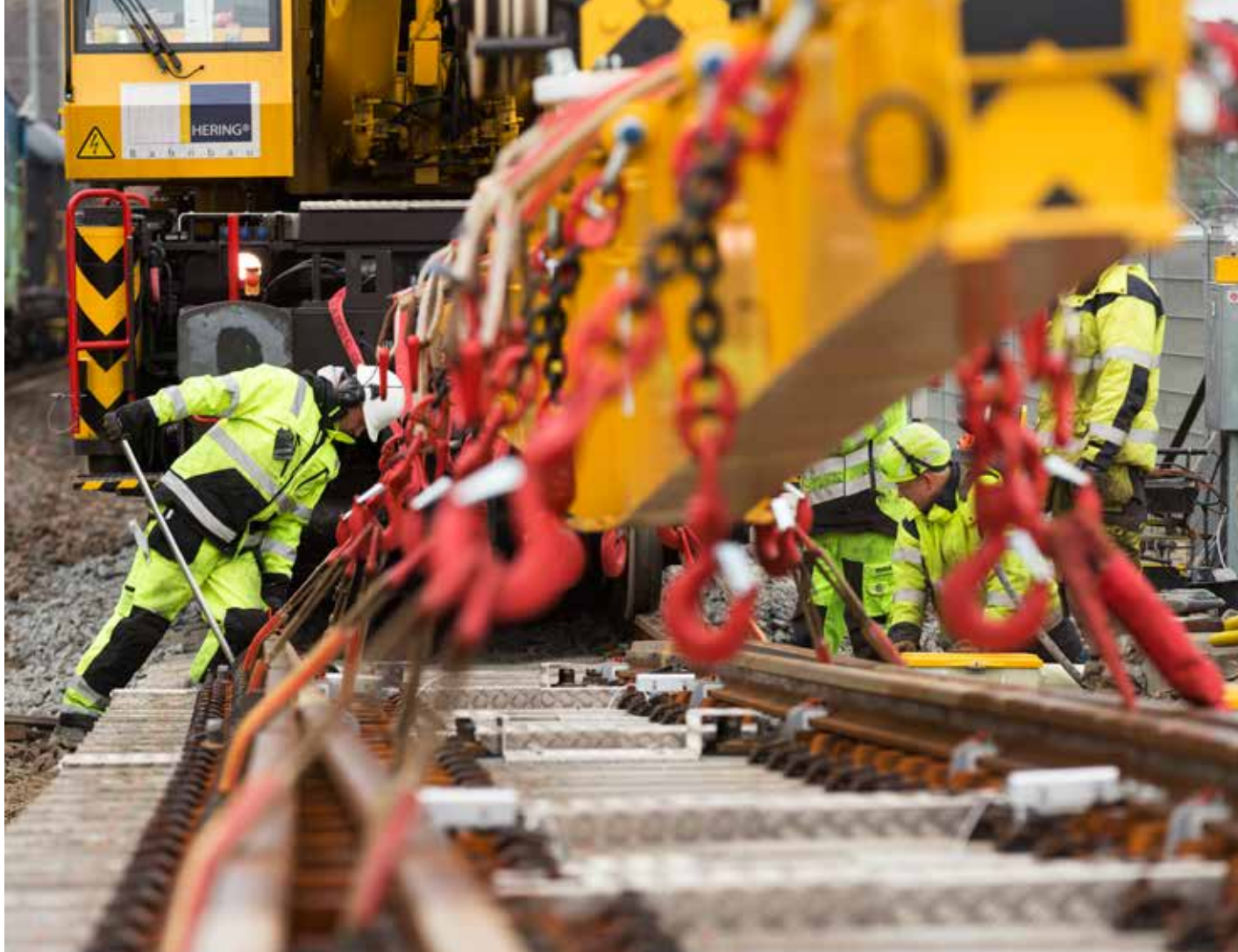
Nya växlar lades in på Västra stambanan vid Sävenäs rangerbangård med hjälp av en spårgående Kirow-kran under påskhelgen. FOTO: KASPER DUDZIK
