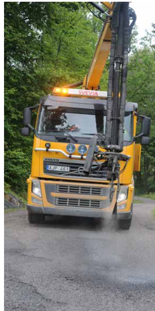
Lagning av sprickor i asfalten. FOTO: KERSTIN ERICSSON.
