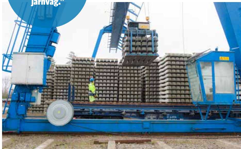
16 Alla gillar tåget. Men det är priset som avgör transportvalet. ILLUSTRATION: SUSANNE ENGMAN 120 000 nya betongsliprar läggs ut på Södra stambanan under årets stora spårbyte. FOTO: KERSTIN ERICSSON
