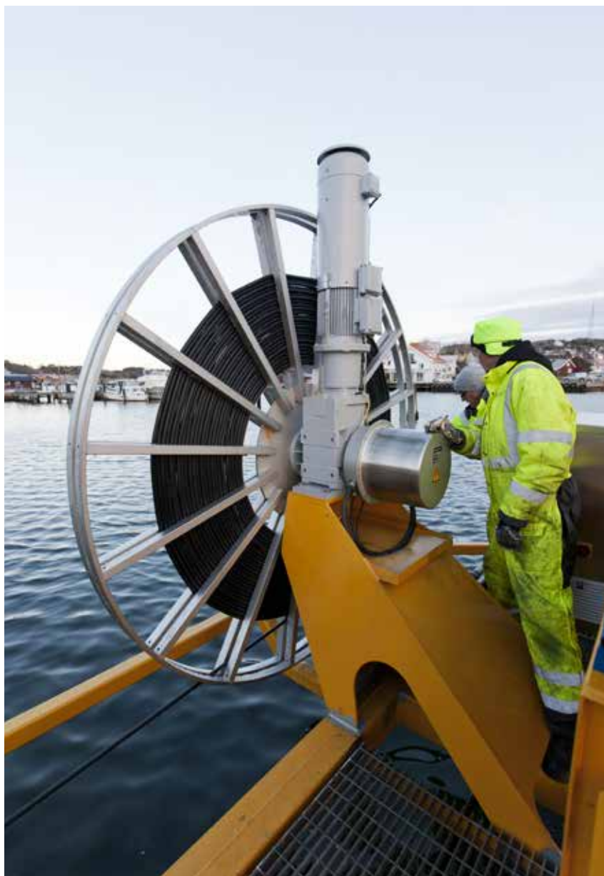
I Hamburgsund har den lindrivna vägfärjan byggts om för att drivas förnybart. Färjan är lindriven men får sin energi via en strömkabel som rullas ut vid varje resa.
