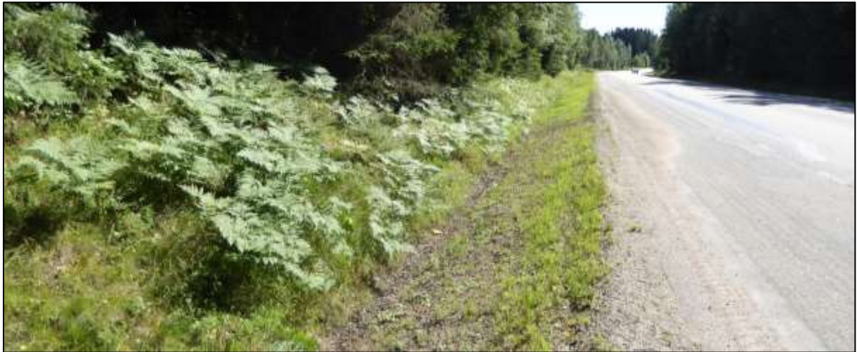
Figur 24. Den mitre delen av väggkanten sett mot söder den 14 augusti. Granarna står nära väggkanten och skuggar samtidigt som de isolerar väggkanten mot områden i öster.
