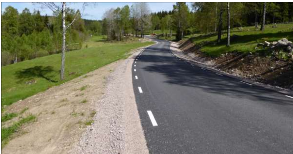
Figur 45. Den södra halvan av sträckan sett mot norr den 5 juni. En mycket blomrik hagmark ligger till vänster.
