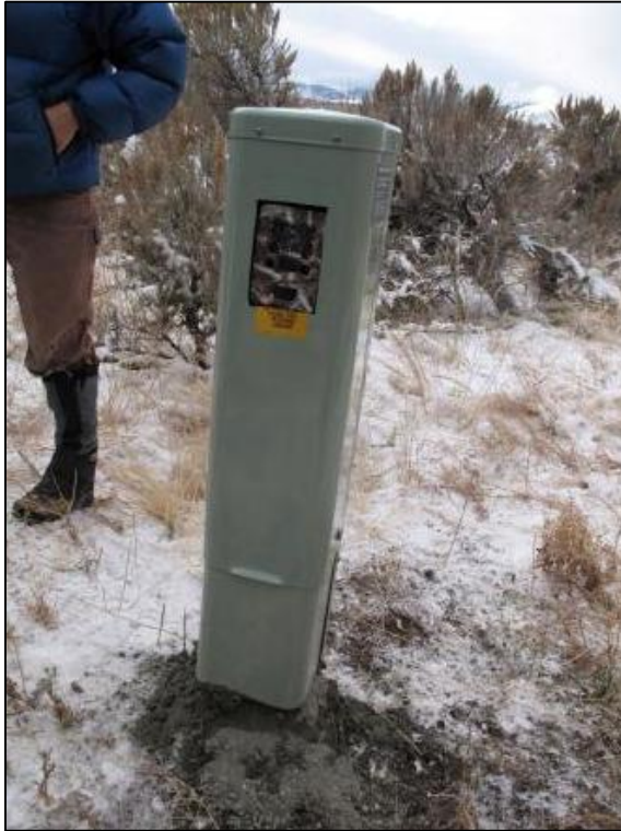
Bild 4. Kamera i säkerhetsbox förankrad i ett betongblock. Foto: Patricia Cramer (USU, UDOT, UDWR)
