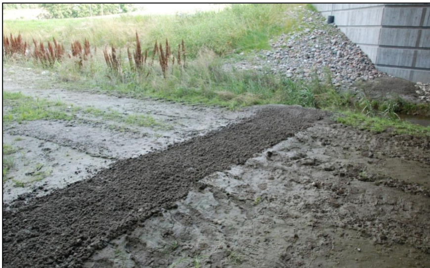
Bild 2. Spårbädd i fauna- passage. Foto: Mattias Olsson (Enviropla- ning)
