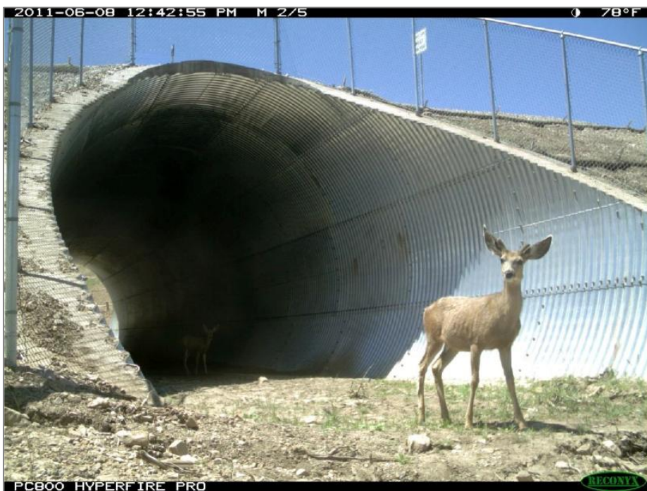
Bild 7. Bild från autokamera; åsnehjortar som använder en trumma under en motorväg i Utah. Foto: Patricia Cramer (USU, UDOT, UDWR)
