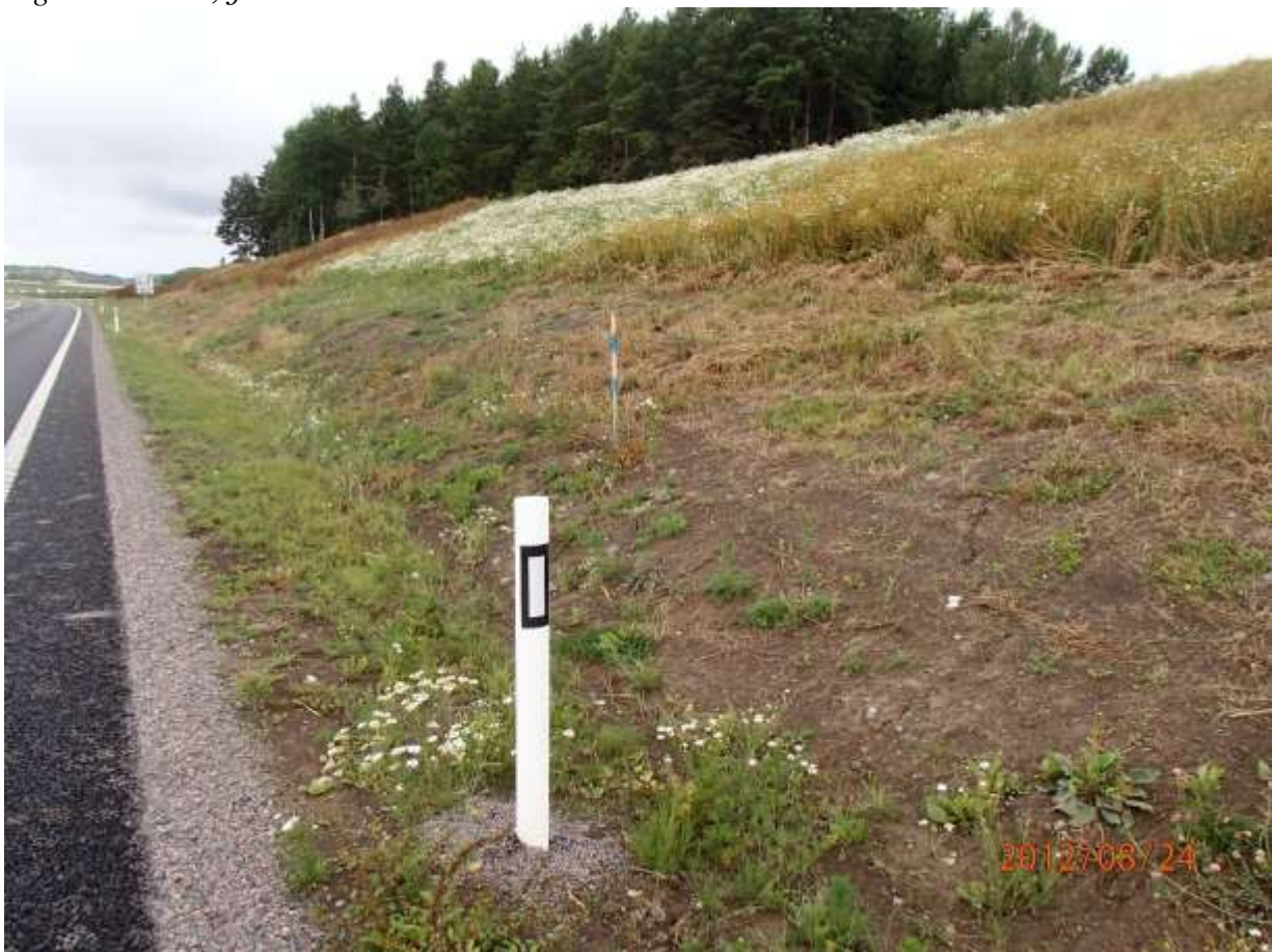
Figur 7. Bullervall, beklädd med vegetationsjord och grässådd.
