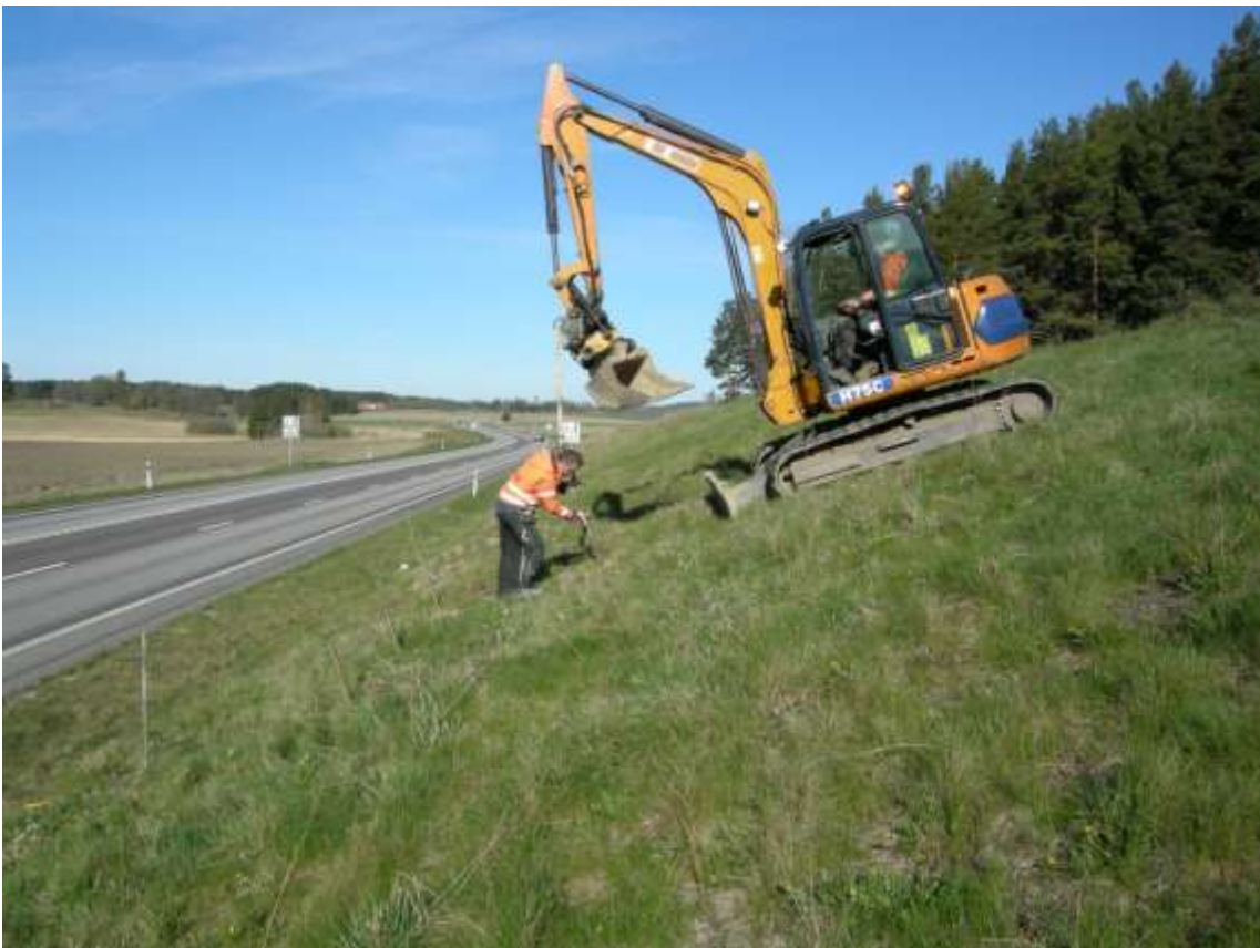
Figur 12. Grävmaskin som användes för att trycka ner sticklingarna i jorden. Vy mot väster.
