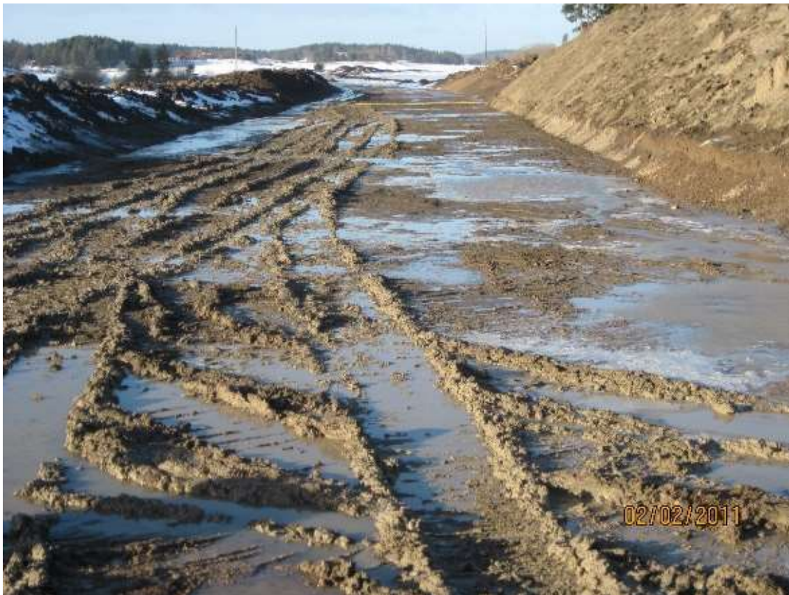
Figur 4. Schakt av terrass. Schaktmassorna utnyttjades till uppbyggnad av bullervallen.
