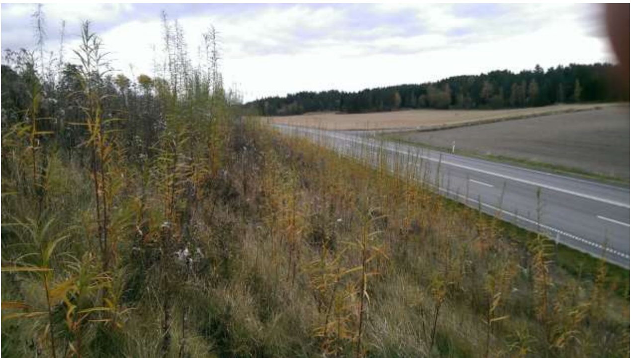
Figur 39. Vallens östra del. Korgviden med längder närmast kamera på 1,5 till 2 m. Vy mot öster.
