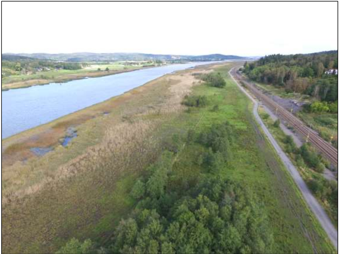
Skötselområde 3, sett mot norr, den 20 september 2017.
