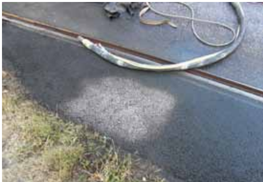
Bild 10-11 Försök till blästring av asfalt för att erhålla ljusare yta
