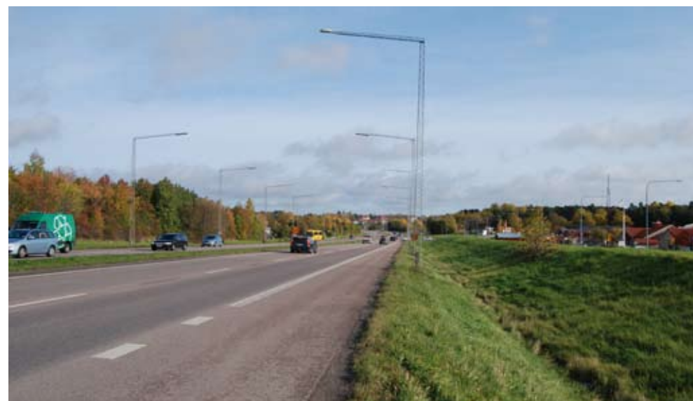
Väg 55 på delen vid Flogsta. Bilden är tagen mot öster.
