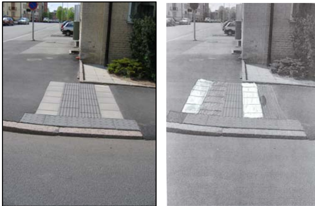
Bild 3 Förslag till placering av sinusplattor som logisk fortsättning på naturlig ledyta (högra bilden)
