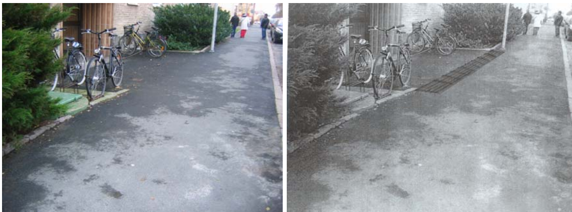
Bild 4 Förslag till lösning på ledning längs entré (högra bilden), längsgående sinusplattor, bredd 35-40 cm. (Observera att stolpen vid ledytans slut måste flyttas).
