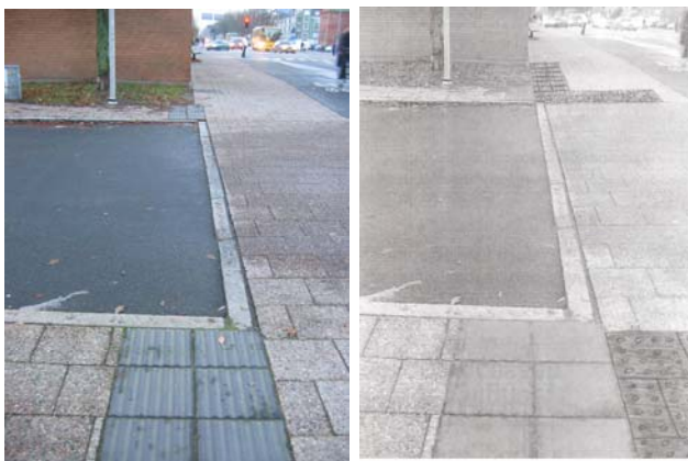
Bild 5 Förslag till placering av kupolplattor som varning vid upphöjd gångpassage (högra bilden). Observera att sinusplattorna även är flyttade 2 rader i sidled enligt princip i Bild 3.
