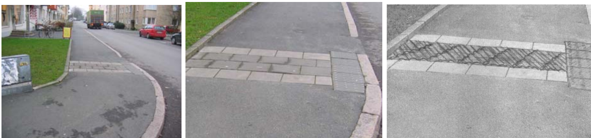
Bild 2 Förslag till diagonalt lagda sinusplattor som ledning och/eller riktmärke (högra bilden)
