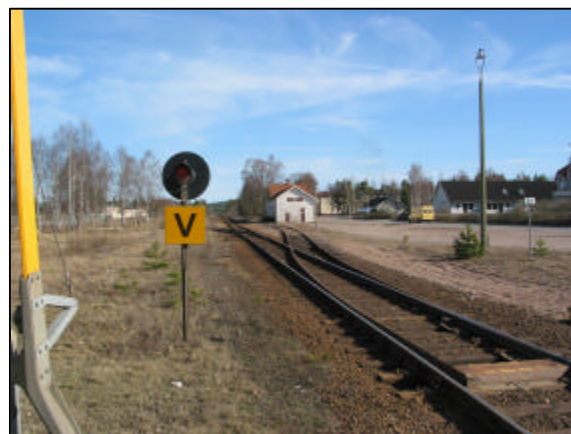
Bild 7 Järnvägsspåret sett söderut
