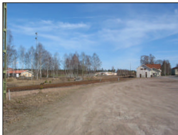
Bild 6 Järnvägsspåret sett söderut
