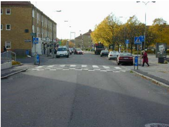
Figur 5.3 Exempel på upphöjt övergångsställe. Foto: Karin Neergaard.
