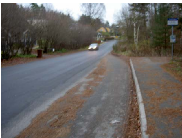
Figur 5.7 Busshållplats på Stationsvägen.
