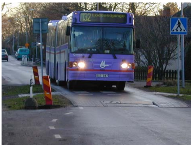
Figur 5.4 Exempel på avsmalning av vägen samt H-gupp. Foto: Per-Gunnar Andersson
