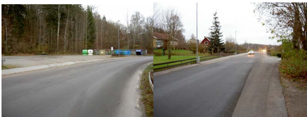
Figur 5.5 Två exempel på sträckor längs Stationsvägen där utrymme bör finnas redan idag till att bredda gångbanan. Återvinningsstationen tv i bild, Stationsvägen söder om korsningen med Trastvägen th i bild.
