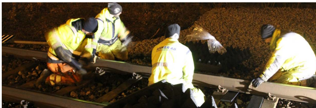
Bild 3: Natligt monteringsarbete av gummipanelerna i Ramlösa. Foto: Lesanco.
