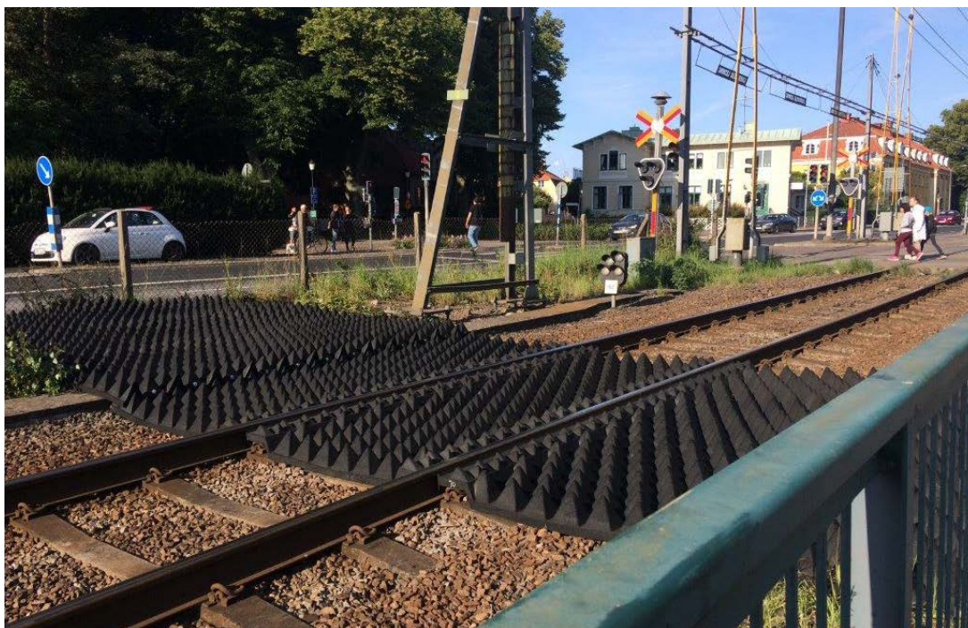
Bild 1: Gummipaneler placerade vid spåret strax öster om korsningen mellan järnvägen och Slottsallén i centrala Kalmar, en av testplatserna. Foto Kristina Johansson Trafikverket.
