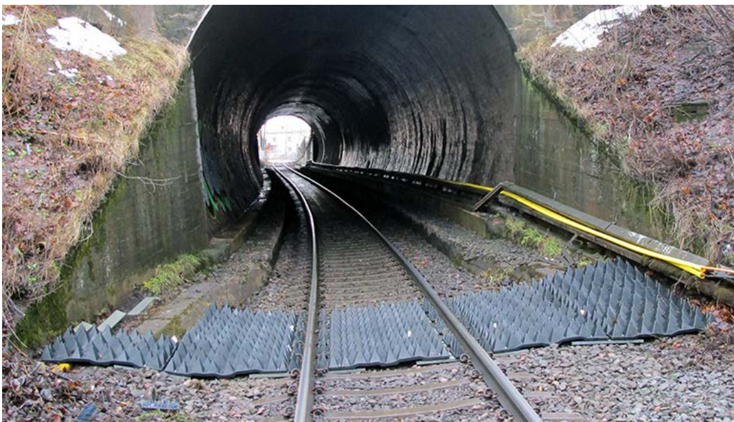
Bild 4: Pågående montering av Strailgrid i Hudiksvall. Foto: GoodRail.
