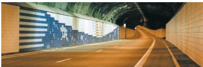
Lundbytunneln, som ingår i Göteborgspaketet, påbörjades 1994 och öppnades för trafik i januari 1998. Tunneln är 2 060 m lång och består av två separata tunnelrör. Genom tunneln har miljön i bostadsområdet Bräcke förbättrats avsevärt.
