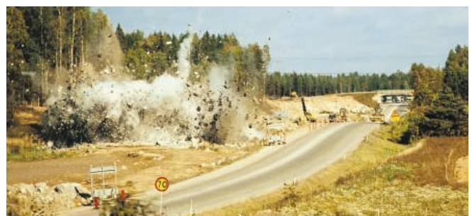
Sprängning för ny motorväg E18/20 mellan Örebro och Arboga.
