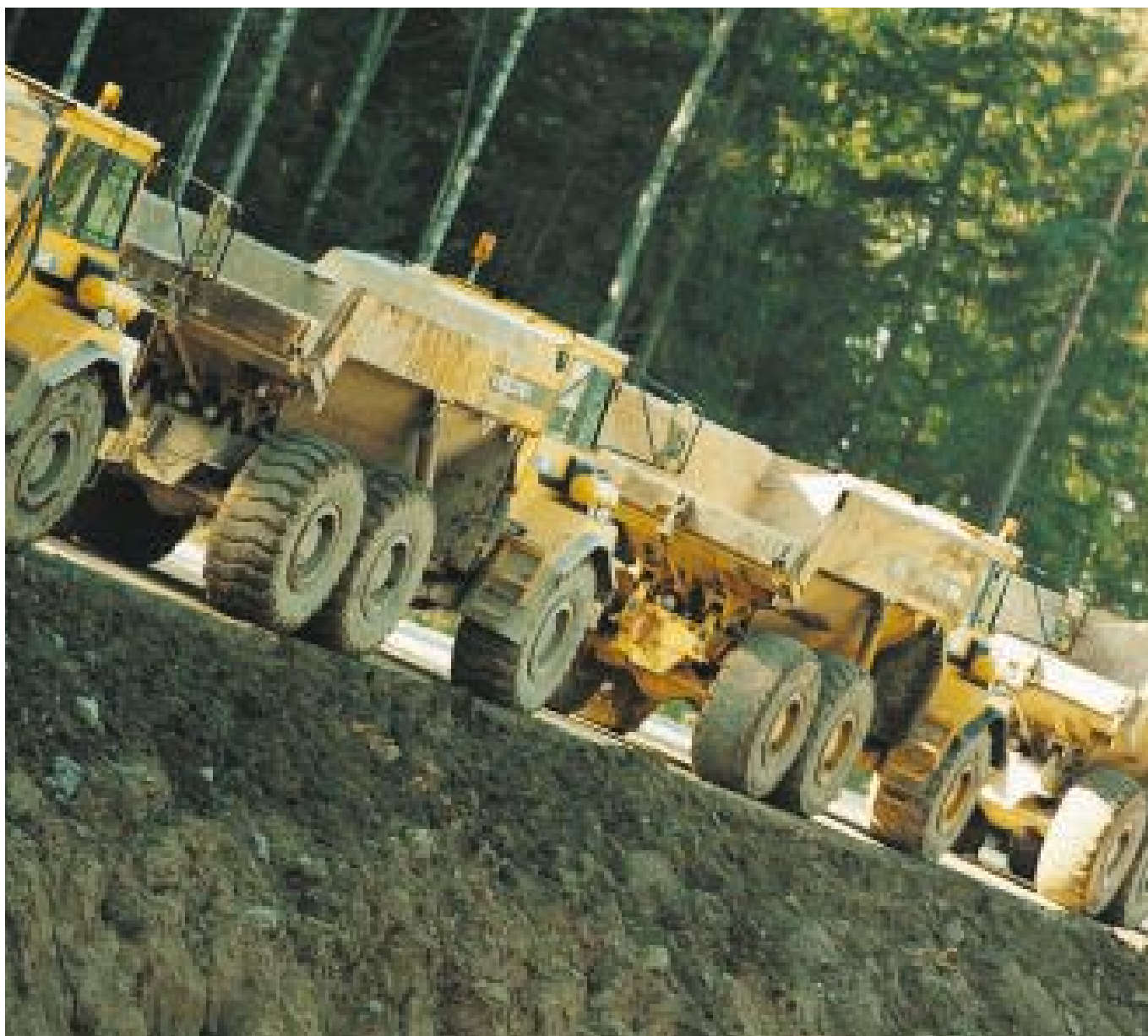
Dumprar i arbete på motorvägen mellan Örebro och Arboga
