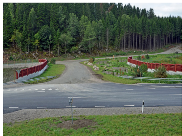
Figur 1. Exempel på en multifunktionell passage – en faunapassage över väg E45 söder om Trollhättan som också har en lokalväg längs ena sidan. Foto: Mats Lindqvist.
