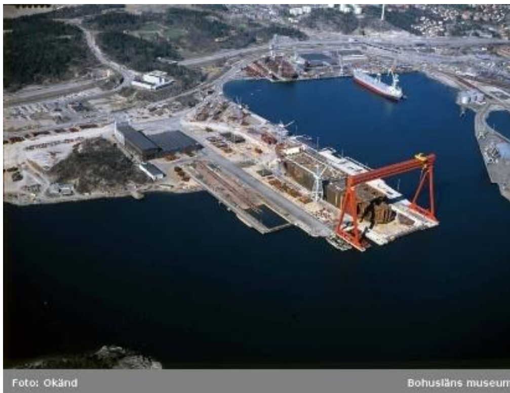
Figur 4. Vy över dockan under byggnation av T/T NANNY – Uddevallavarvet. 10
