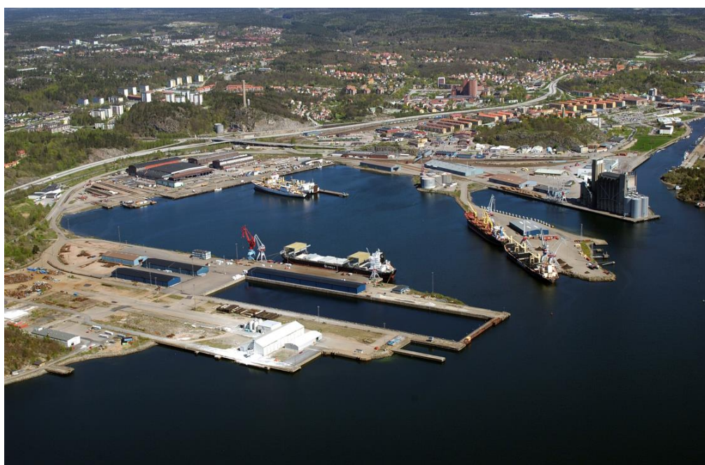
Figur 5. Uddevalla hamn med Sörvikskajen (i förgrunden) respektive Skeppsholmspiren och Badökajen (t.h.) idag.
