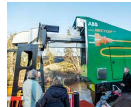
Det är den mekaniska anslutningsförmågan som testas på laddstationen på Ljusterö.
