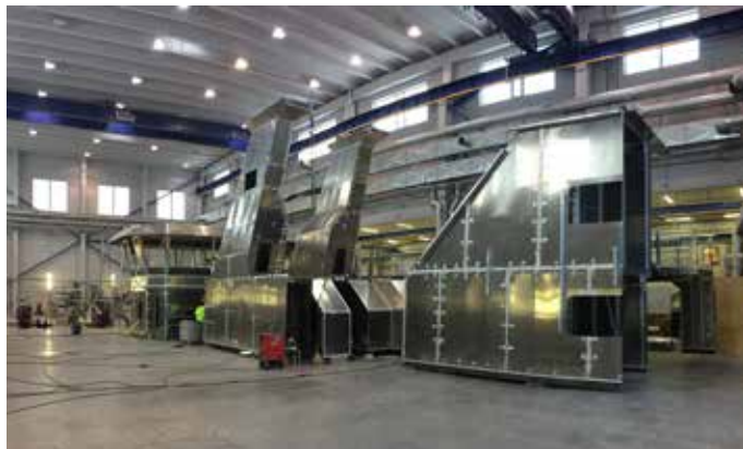
Allt aluminium byggs på varvet i Nasva på Ösel. På bilden syns styrhytt och apparatur, två skorstenar samt blivande aktra trapphus. Foto: Fredrik Skeppstedt
