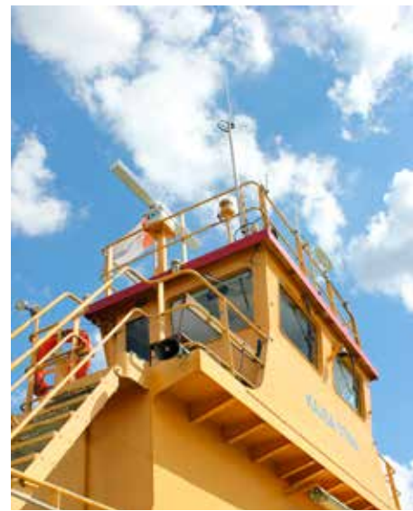
Före. Kajsa-Stina med den gamla sidohytten.
