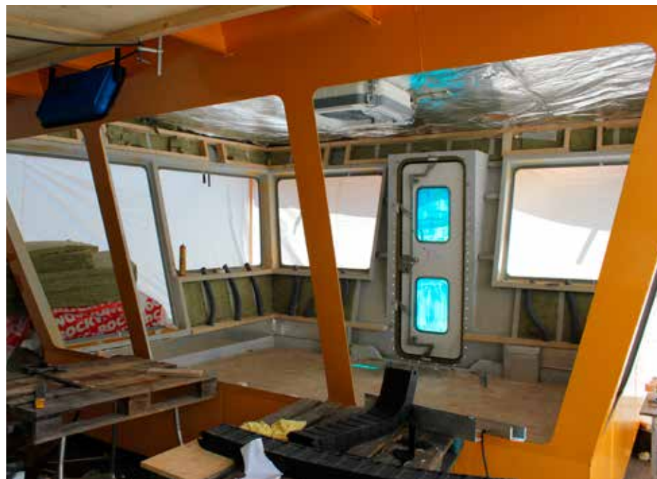
Byggarbetsplats. Kajsa-Stinas nya sidohytt börjar sakta ta form.
