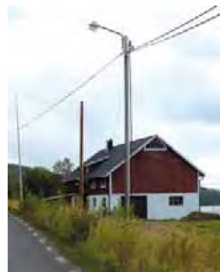
Belysningsstolpar är ett av de objekt som bidrar till en vägs karaktär.
