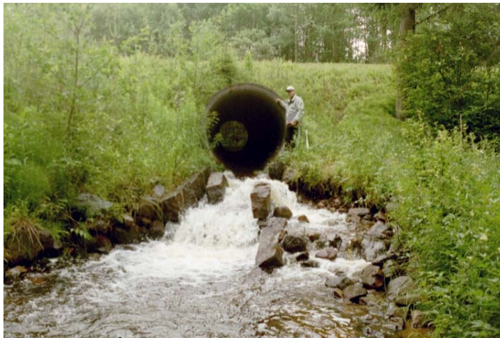
Vägtrumma i Åbergsvassla sommaren 2002.
