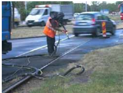
Bild 10-11 Försök till blästring av asfalt för att erhålla ljusare yta
