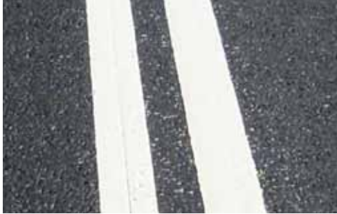
Bild 9 Vit vägmarkeringslinje på asfaltyta använd som skiljelinje
