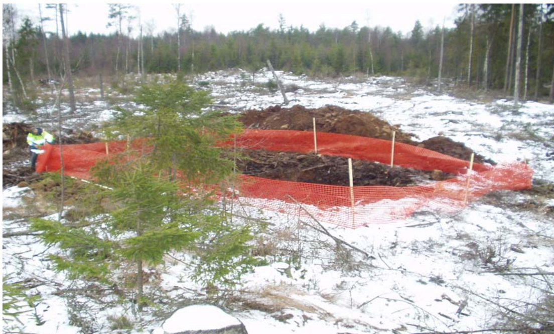
Figur 2.3 Djupare provgropar får ej lämnas öppna utan bevakning eller inhägnad. Foto: Peter Carlsten
