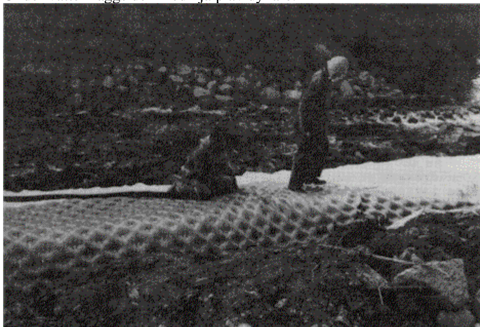
Fig 12 Fyllning med betong
