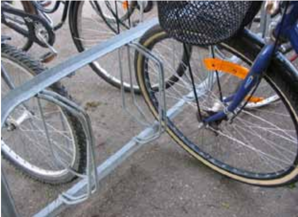
Förzinkade stålställ kan relativt lätt deformeras. Här är hjulhållarna ihoptryckta och därmed oanvändbara. (Hågalsskolan, Uppsala). Foto: Petra Halvarsson
