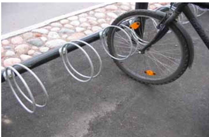
Ett vanligt hjulhållande cykelställ i Sverige består oftast av en ram eller som på bilden bakstycke i form av en tvärslå av metall. På denna finns hjulhållare som även kan kallas för bågar. Avståndet mellan cyklarna i ett cykelställ kallas för fackdelning eller centrumavstånd. Foto: Petra Halvarsson
