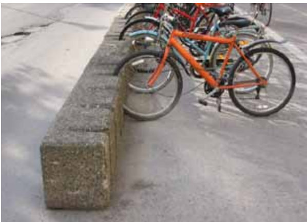
Hjulhållande betongställ fungerar bra som avgränsning men dåligt som stöd för cyklar (Östra Ågatan Uppsala). För att få bra avgränsning och bra ställ, görs istället som i bilden nedan. Foto: Petra Halvarsson
