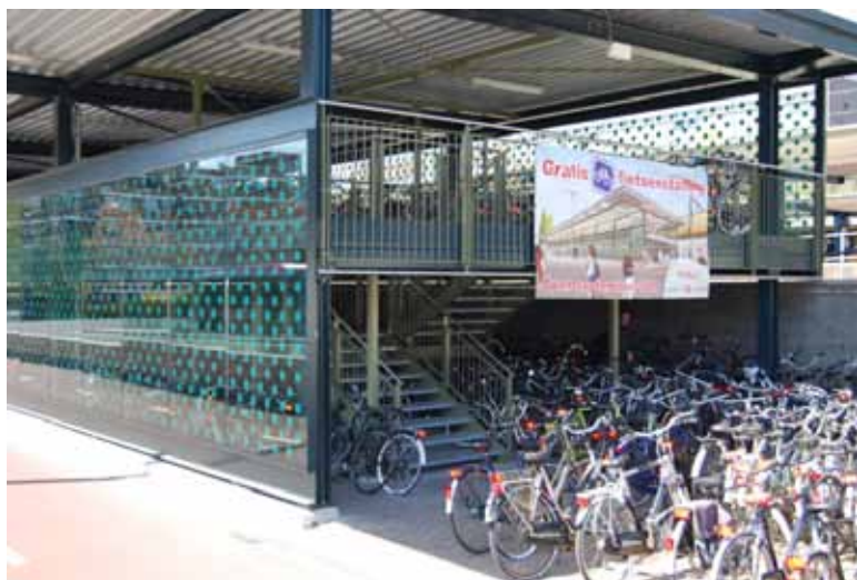
Cykelgarage i Enchede, Nederländerna. Väggarna är av glas vilket gör att man ser såväl in som ut ur garaget. Foto: Trivector Traffic
