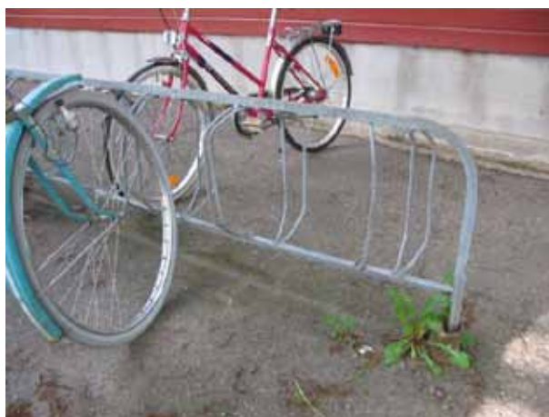
Varmförzinkat hjulhållande stålställ utanför Hågaladsskolan i Uppsala. En mycket vanlig cykelställstyp i Sverige. Foto: Petra Halvarsson
