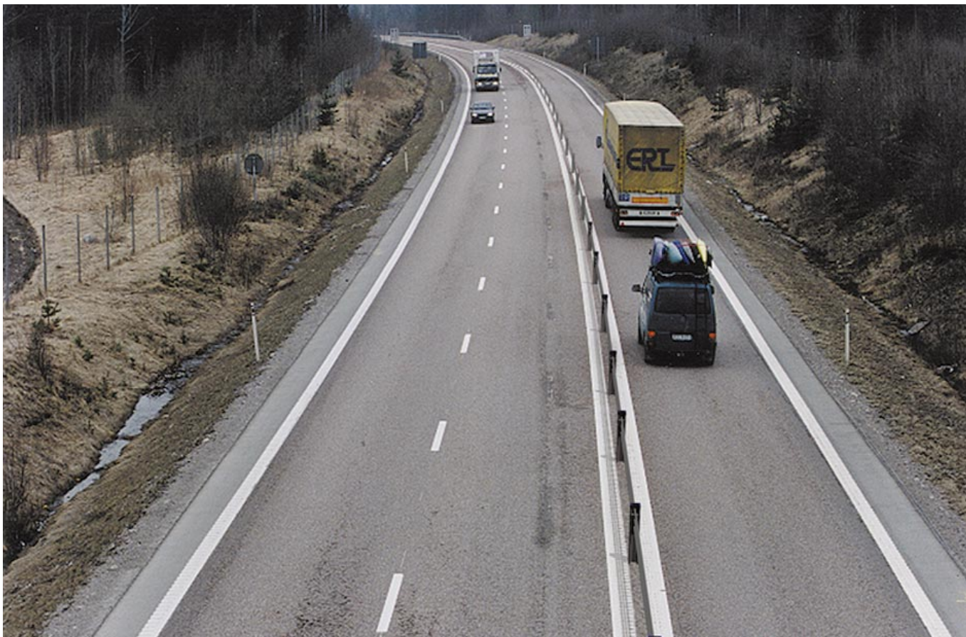
Körbanan har delats in i två körfält i den ena riktningen och ett i den andra. Varannan till var tredje kilometer växlar en- och tvåfältigheten riktning.
