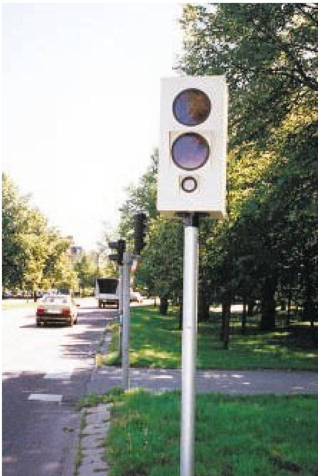
För att minska de allvarliga olyckorna på E4 mellan Hudiksvall och Iggesund har under 1998 sju automatiska trafikövervakningskameror installerats. I utrustningen ingår en radar som mäter hastigheten på alla fordon som passerar och som är kopplad till kameran som fotograferar de bilar som överskrider hastighetsgränsen.
